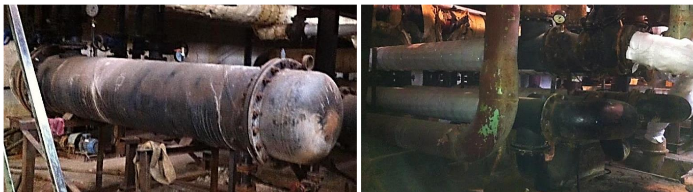
Рисунок 24. Теплообменные аппараты ЦТП ООО "Север"
