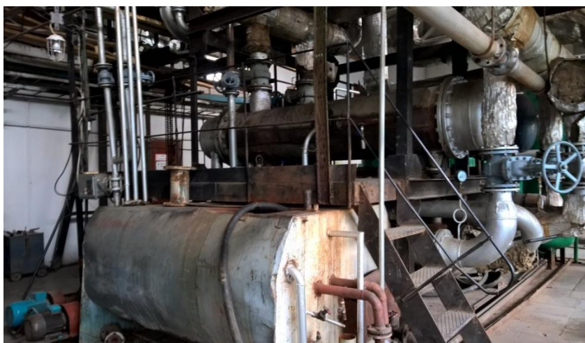
Рисунок 14. Пароводяные подогреватели котельной МУП "ВТЭК", г. Волчанск
