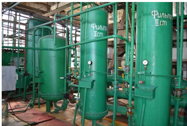
Рисунок 7. Водоподготовительная установка Котельной ВМЗ
